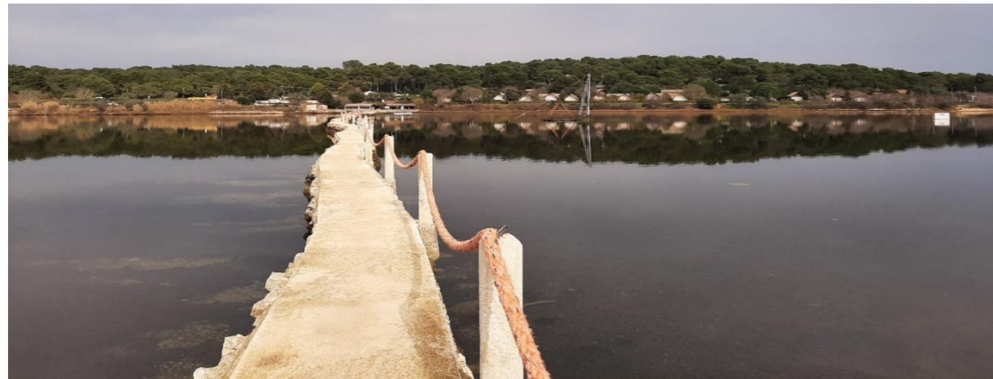
Slika 64 Pogled na pješački most koji premošćuje Šćuzu (autorska fotografija)
